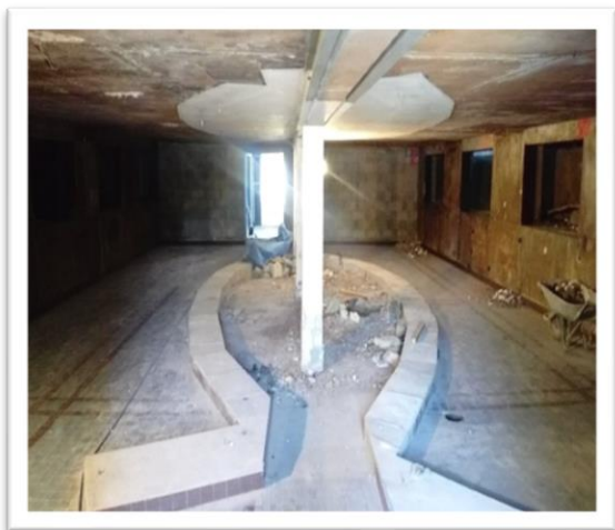
ÉTÉ 2018 : démolition et désamiantage
