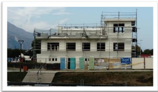
JUILLET 2018 : installation du chantier de réhabilitation
